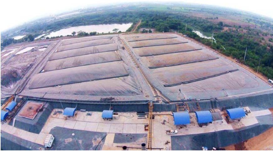
ภาพตัวอย่างระบบ Biogas ที่ผมเป็นผู้ออกแบบและให้คำปรึกษาด้านงานก่อสร้างและเดินระบบ
